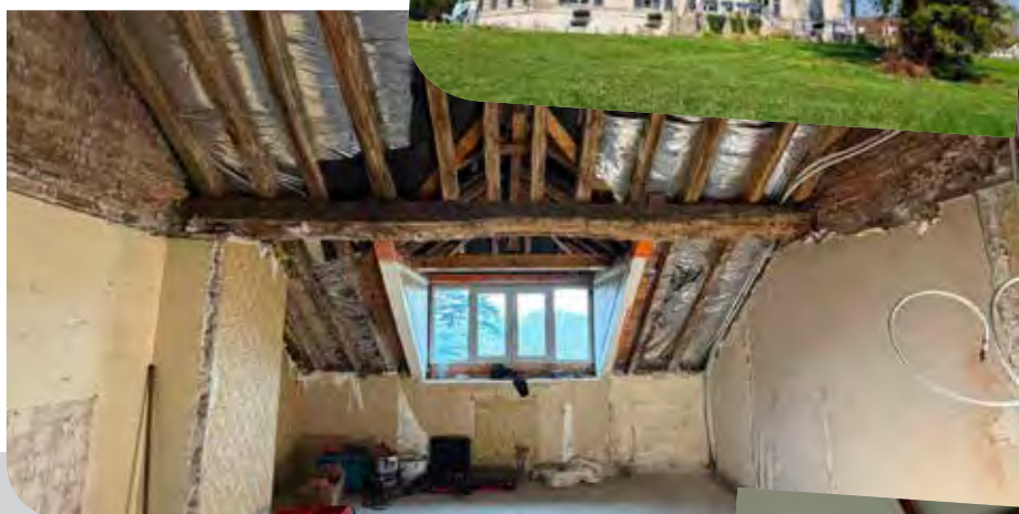
↕ Elargissement de passage et reprise de charpente
