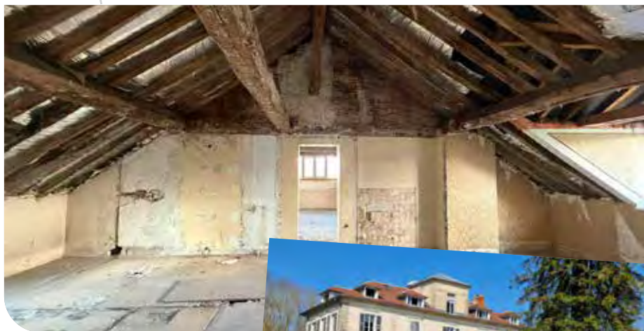
↕ Elargissement de passage et reprise de charpente
