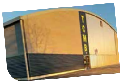
o o o Terrains de Tennis couverts et Padel
